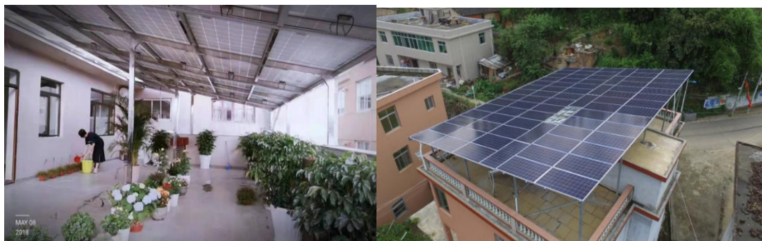
光伏阳光棚现场照片
