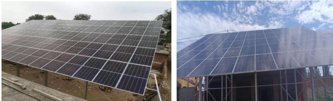
光伏庭院现场照片
